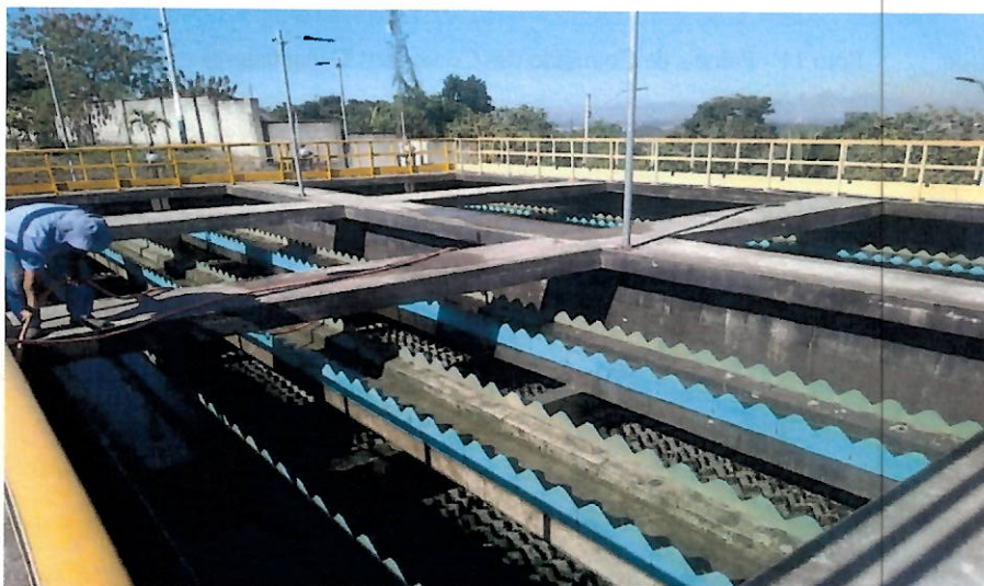
Foto 09 – Realização da limpeza de um dos decantadores.
