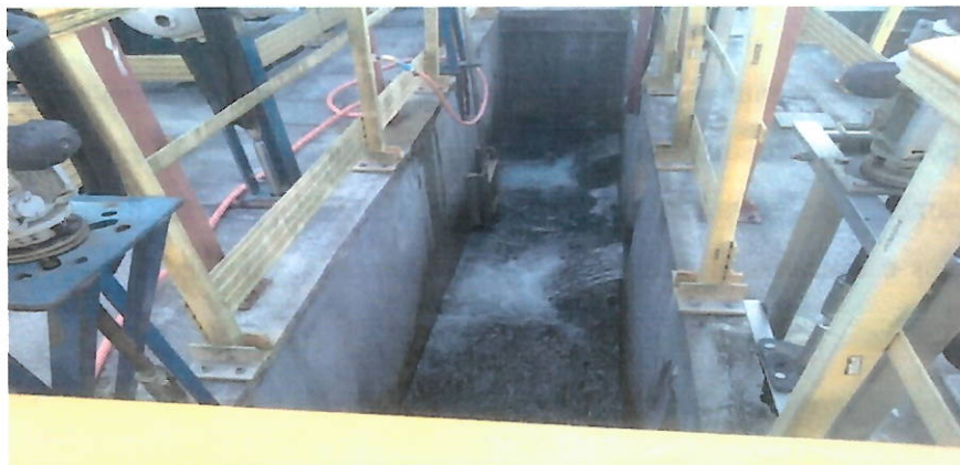
Foto 10 - Canal de Água Decantada.
