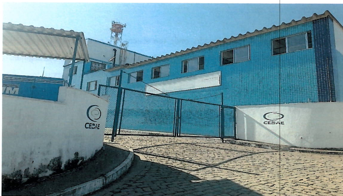
Foto 01 - Entrada da Estação de Tratamento de Água Campos Elíseos.
