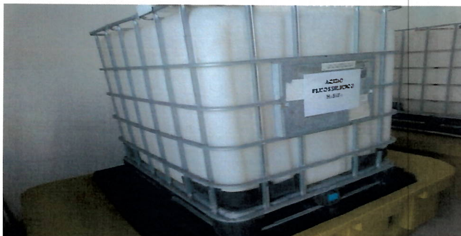
Foto 19 – 2 Reservatórios de 1000L de Ácido Fluossilícico.
