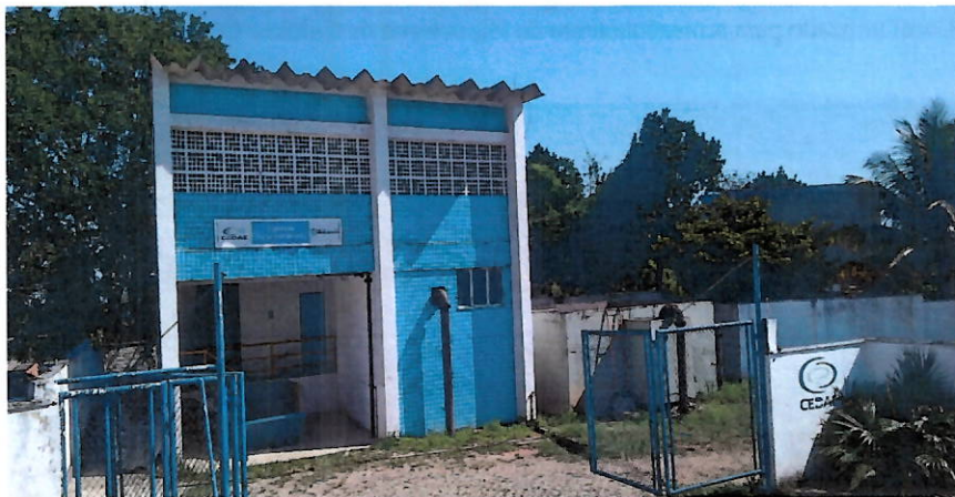
Foto 20 – Prédio do Sistema de Tratamento de Lodo.
