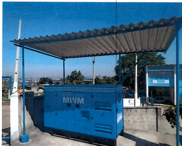
Foto 25 -- adequação realizada (gerador instalado).
